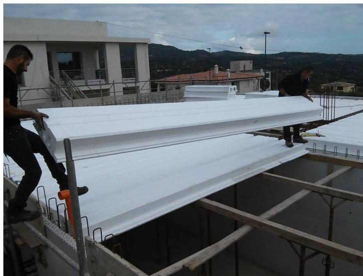
**Thermo Solaio**, grazie all'utilizzo dell'EPS garantisce un peso ridottissimo, circa 7 kg/mq, che equivale ad un abbassamento del peso proprio in opera di circa il 30% rispetto alla tradizionale pignatta, oltre a possedere un elevato potere isolante. Il peso ridotto inoltre permette una facile posa senza l'ausilio di gru o simili
