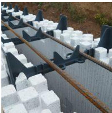
I distanziatori plastici in polipropilene, sono gli unici al mondo ad aver integrato le sedi per la posa del ferro orizzontale, e di quello verticale, garantendo il rispetto delle prescrizioni dettate dal progettista strutturale. Il passo di default delle armature sarà 20x30 (verticale e orizzontale), ma in zone particolari (tipo angoli, architravi, spalle finestre etc...) si potrà infittire a 10x30cm.
